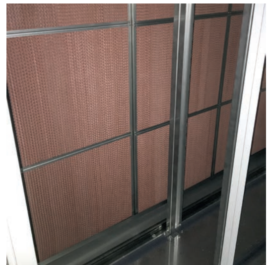
'Voor de indirecte adiabatische koeling wordt pakketbevochtiging toegepast, waarbij gebruik wordt gemaakt van hemelwater.'
